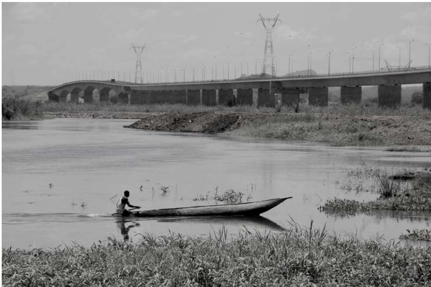
Ponte Guebuza, Rio Zambeze, Caia
